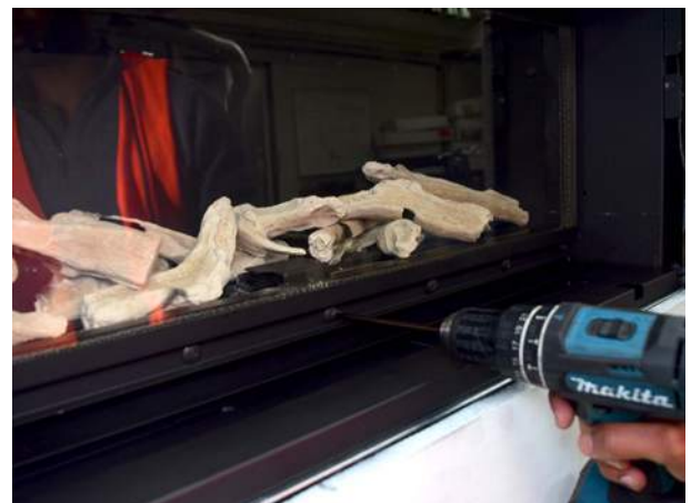
Remove door screws
